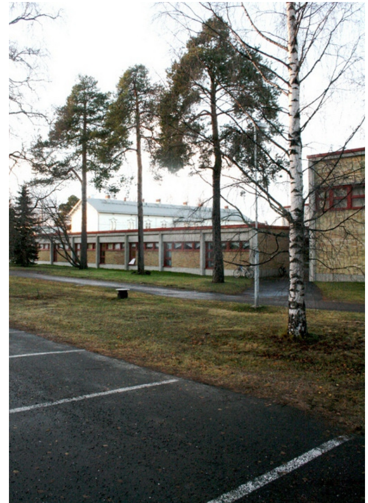
Kuva 3 Koulurakennukset kirkon puolelta nähtynä
