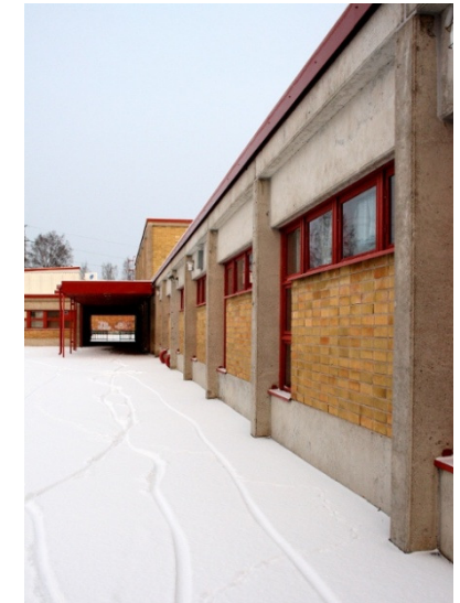
Kuva 15 Julkisivua ja sisätiloja rytmittävät näkyviin jätetty pilari-palkki-rakenne.
