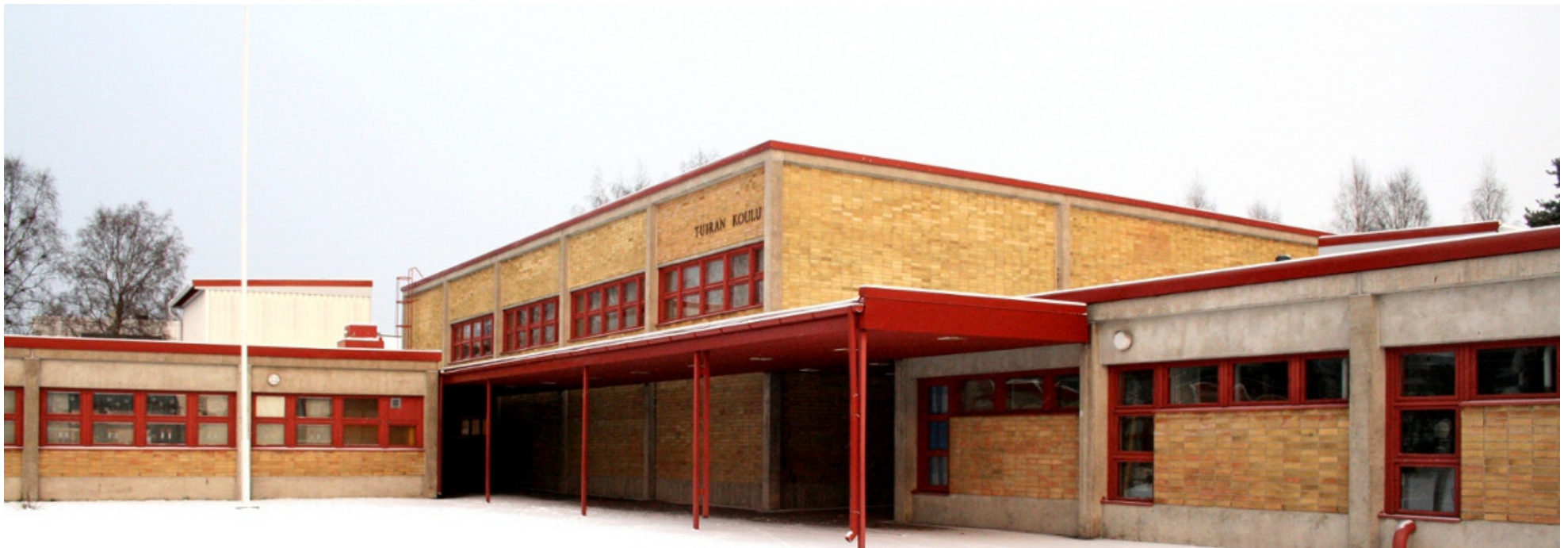
Kuva 3 Laajennuksen kolme päämassaa on yhdistetty ulkokatoksella
